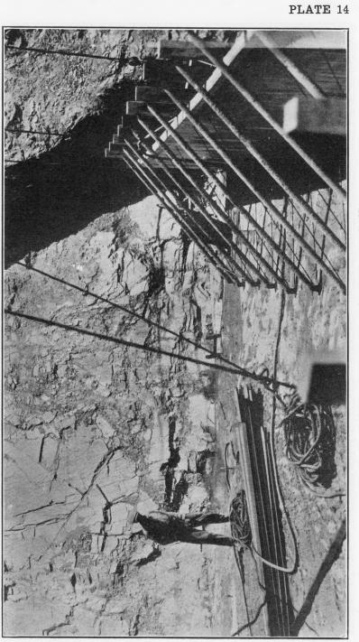
PLACING CONCRETE AGAINST EAST ABUTMENT.
